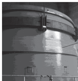
图1 玻璃钢筒体牛腿梁图
